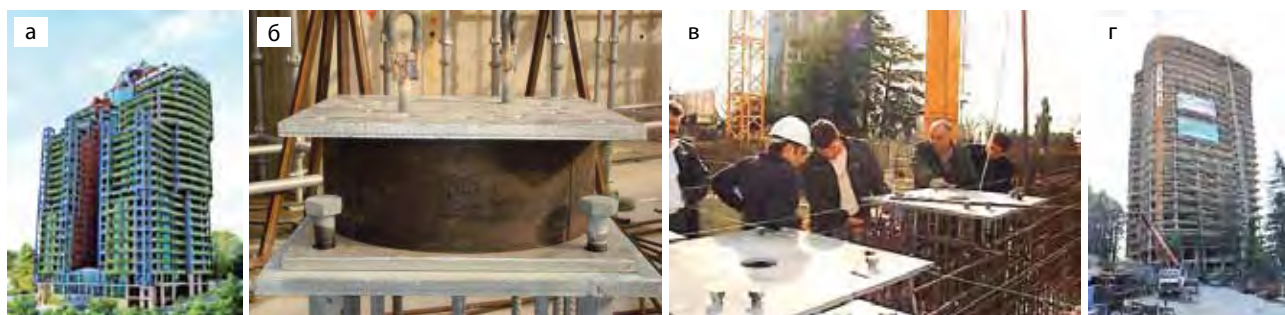
Рис.11. Жилой дом с системой сейсмоизоляции по Курортному проспекту в г.Сочи: а — перспектива первоначального варианта здания; б — РМО со свинцовым сердечником; в — устройство закладных пластин под опоры; г — новый вид здания.
