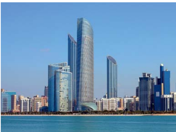
Рисунок 2 — Здание в г. Абу-Даби. Объединенные Арабские Эмираты. Сейсмически активный район. Высота здания 829 м. В центре самое высокое здание, построенное в сейсмически активном районе
