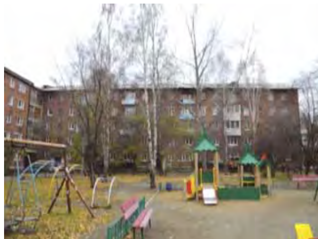
Рис.3. Жилой дом — представитель зданий серии 1-306, г.Иркутск, ул.Байкальская, 200а
