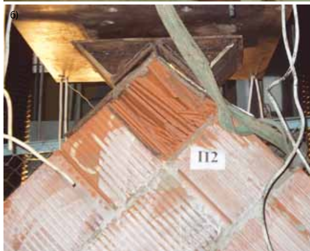
Рис.6. Разрушение образцов серии C2
