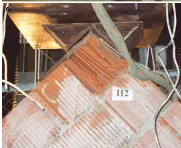
Рис.6. Разрушение образцов серии C2
